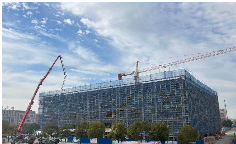
图 1-5 体育馆项目建设
